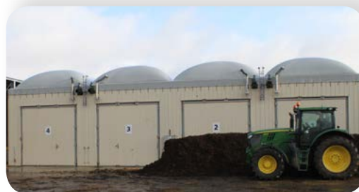
► Les 4 garages de méthanisation
