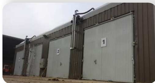
► Les 4 garages de méthanisation
