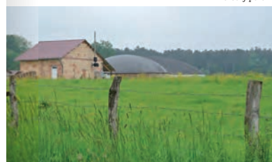
Local cogénération et digesteur
