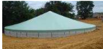
Modification de la réglementation ICPE (juin 2021) Obligation de couverture des cuves de stockage
